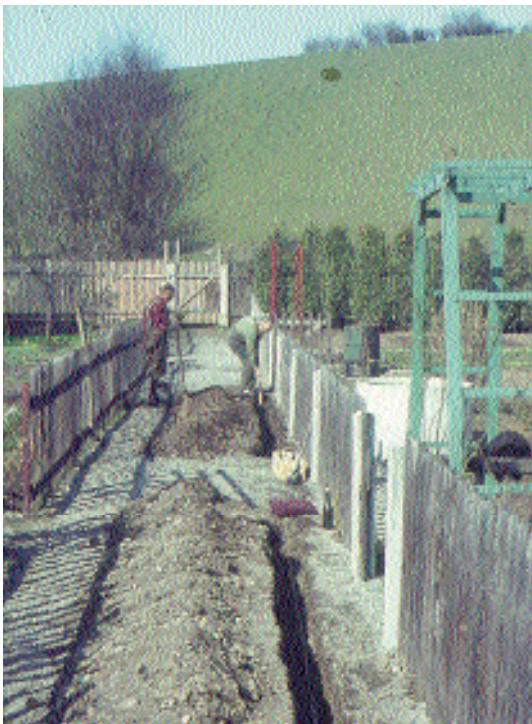
Bau der Wasserleitung
