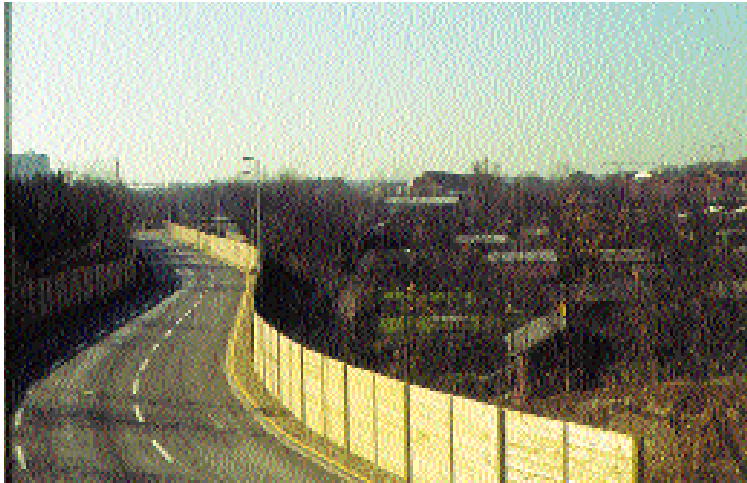
Umleitung des Mittleren Ringes beim Bau des Brudermühl-Tunnels – die 3-spurige Straße verläuft zwischen der Gartenanlage und dem Israelitischen Friedhof
